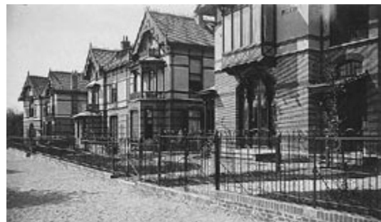
Links de in 1972 gesloopte dubbele villa's 2, 4, 6 en 8. Rechts het linker deel van de dubbele villa hoek Nieuwe Parklaan/hoek Wagenaarweg. Fotograaf kijkt richting Den Haag. Foto uit 1900
